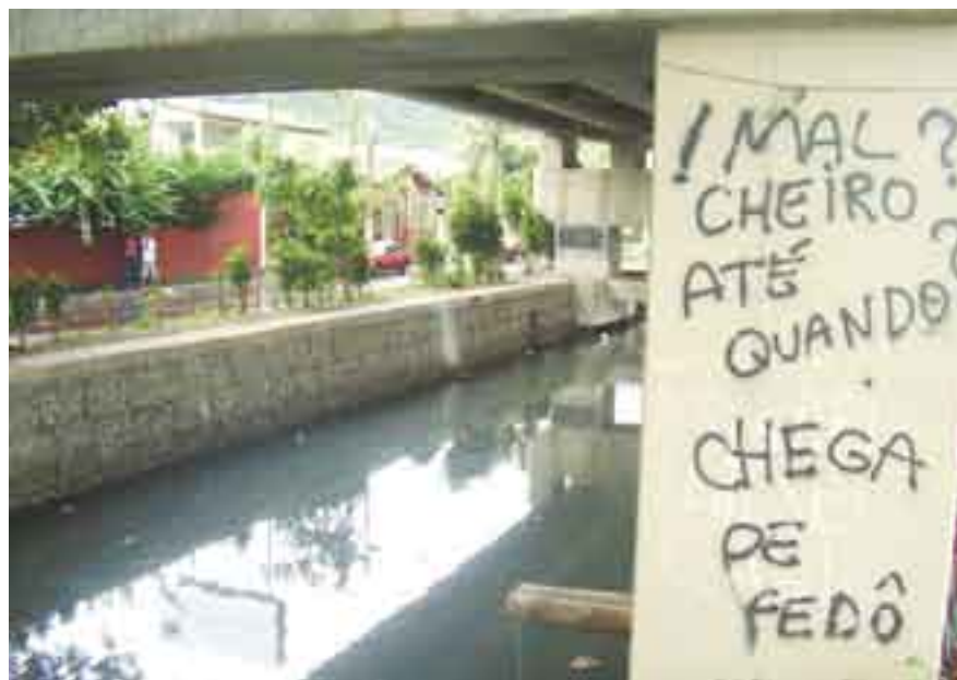
O valão é um foco de incidência de mosquitos.
